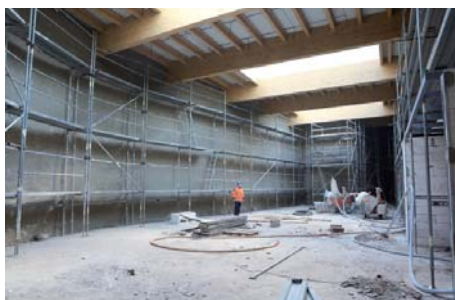
JÍDELNA V budoucí prostorné jídelně finišují zednické práce.
