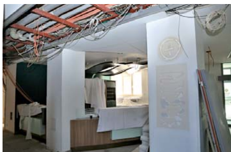
RECEPCE Bývalá i budoucí recepce na svoji rekonstrukci ještě čeká.
