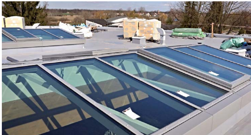
STŘECHA Ve střeše nad jídelnou přibyla obrovská skleněná okna.
