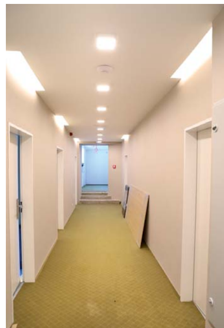
CHODBY Svítidla na chodbách jsou umístěna i ve speciálních výklencích nad každými dveřmi.
